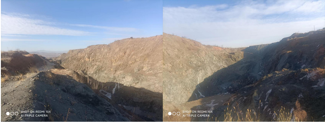
图 3.2-1 北侧采坑现状照片
