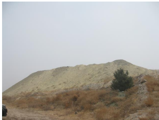
图 3-2 二采区排岩场现状
