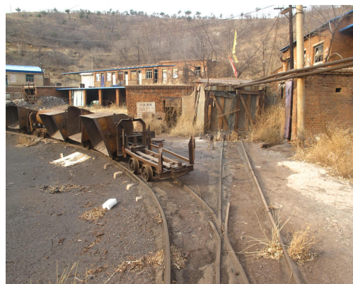
照片 3-2 工业场地现状
