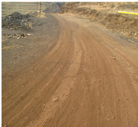
照片 3-3 运输道路现状
