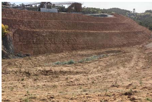
照片2-8 2023 治理区 1 治理复垦后的场地
