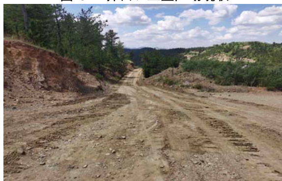
图 3-4 运输道路现状
