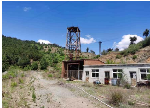
图 3-2 井口、工业广场现状
