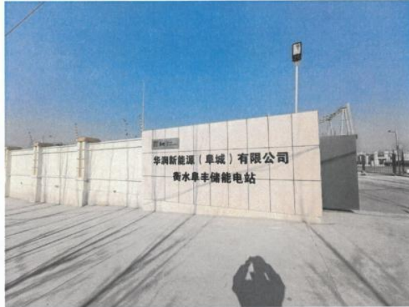
项目现场照片
