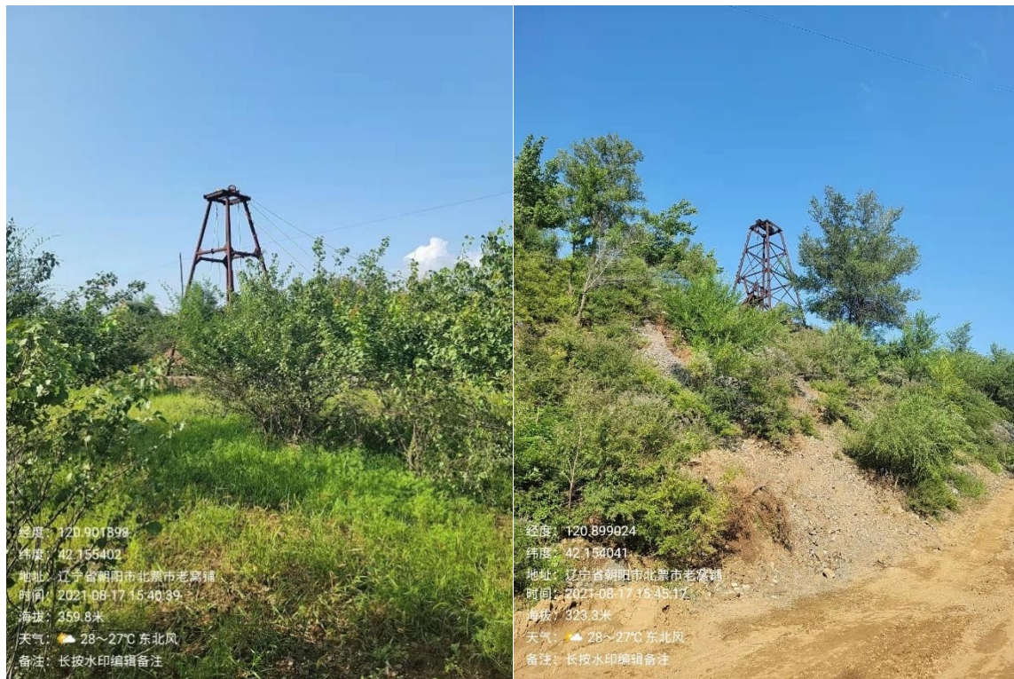
南采区拟拆除井口情况 图 3.2-2 采区现场照片
