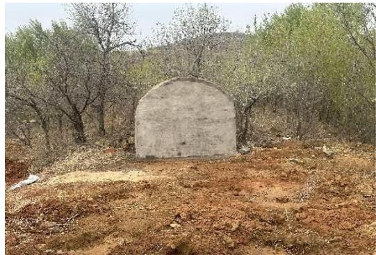
图 2-5 井口 XJ12 回填、封堵后的场地
