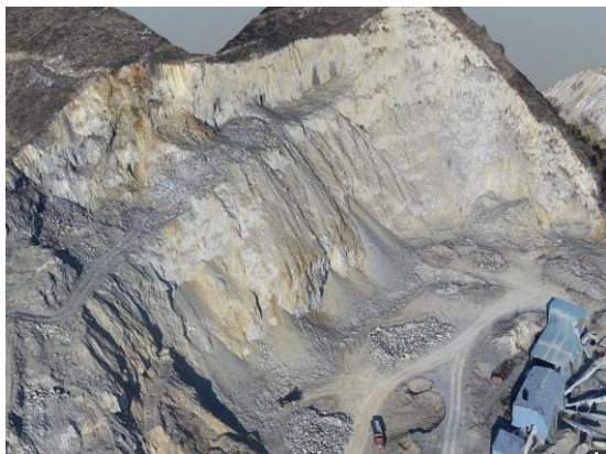
图 3-2 露天采场 CK1 现状
