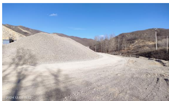
图 3-6 工业场地中的临时弃渣堆
