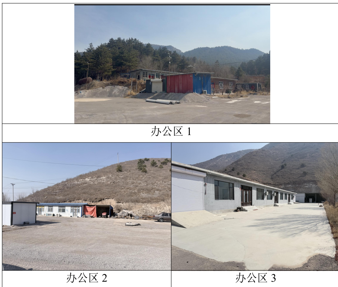
照片 3-3 办公区照片
